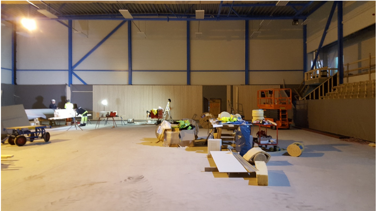
Innvendig montasje uke 47 – 2016
