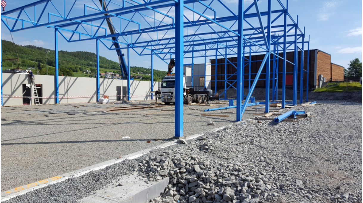
Stål og betong uke 23 – 2016
