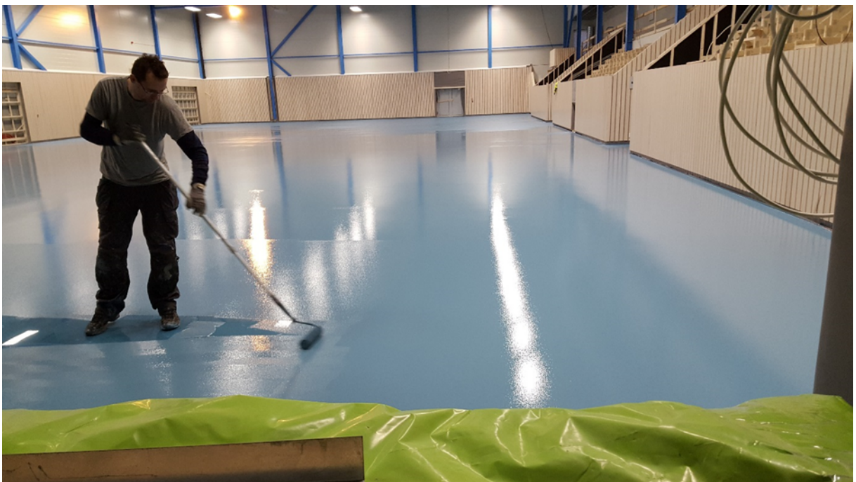
Legging av gulvdekke uke 49 – 2016
