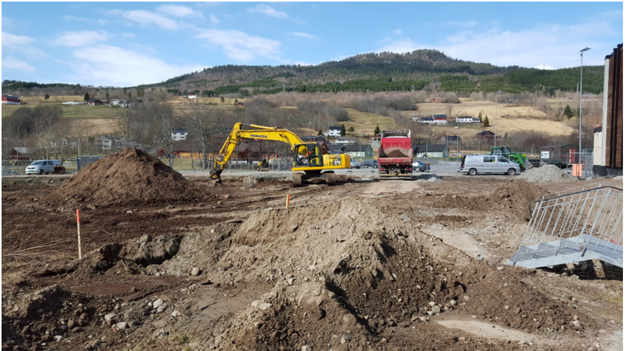
Oppstart graving uke 15 – 2016
