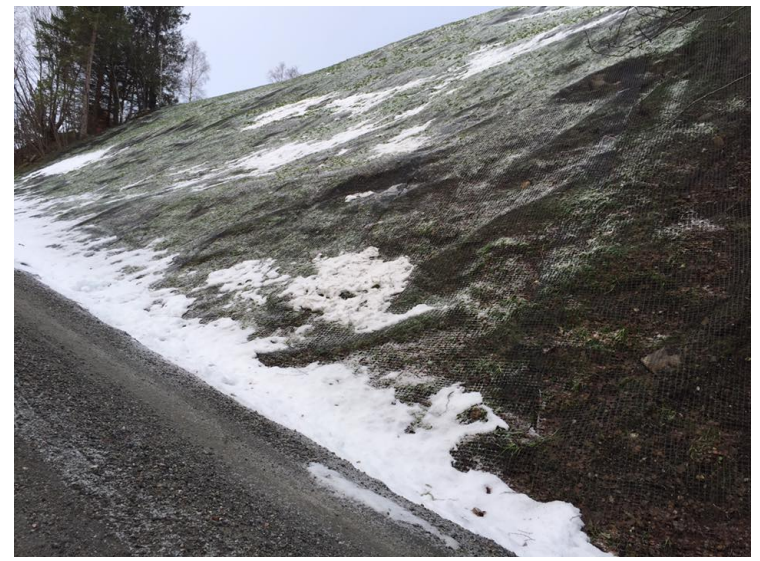
Bilde 4 Erosjonssikring Bjørbakken
