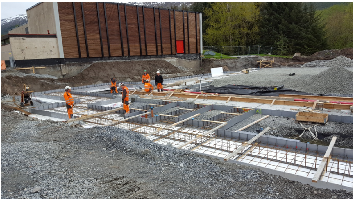
Grunn og fundament uke 20 – 2016
