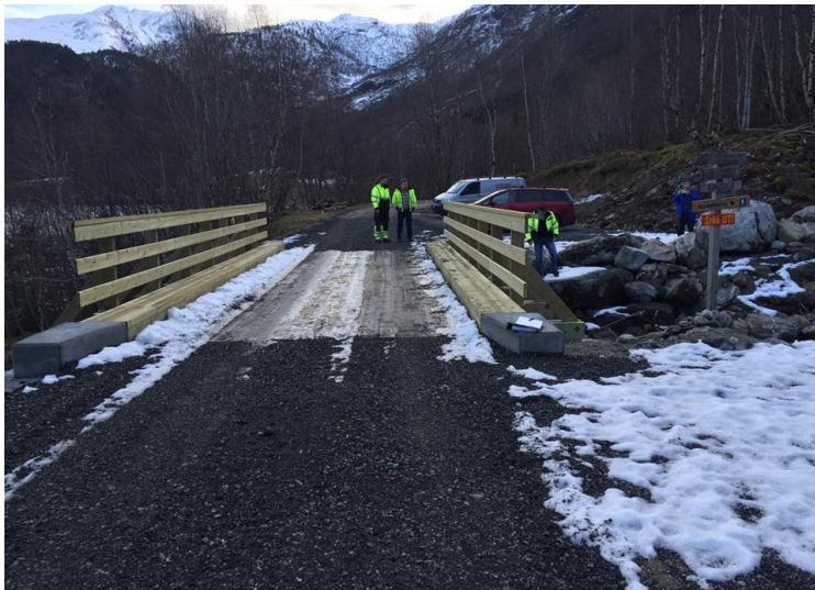
Bilde 1 Røndøla bru
