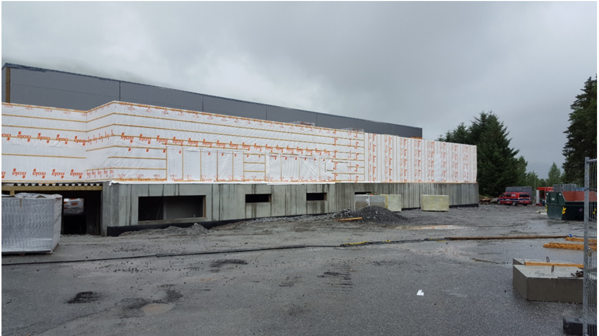
Tett bygg uke 32 – 2016
