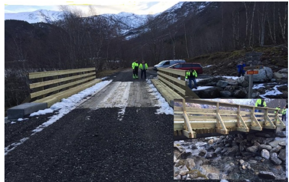
Bilde 1 Røndøla bru
