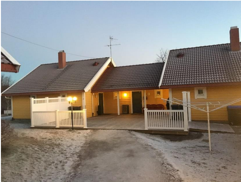
Foto: Anette Sæland. Ny platting og rekkverk med levegg ved Skogheim 3
