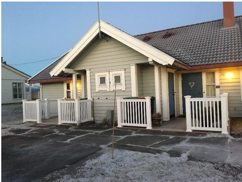
Foto: Anette Sæland Nytt rekkverk ved Skogheim 2
