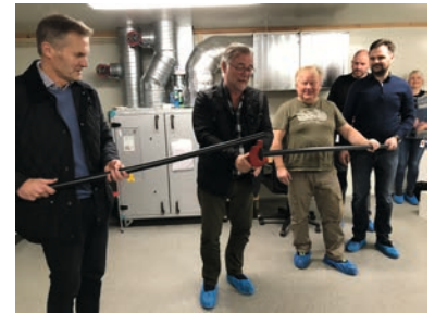
Åpning av renseanlegget Eidsvåg vannverk, Solbjøra
