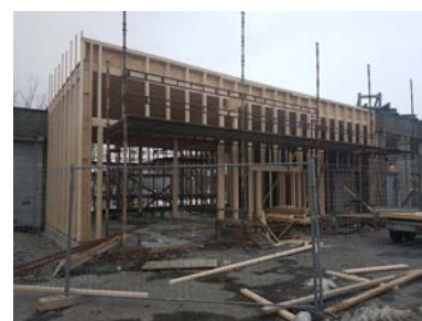
Garasje til miljøbil og vedproduksjonslokaler
