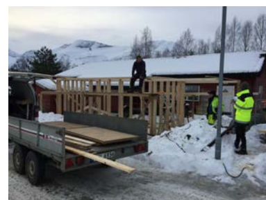
Bygging av utelager/vognskur ved Eresfjord barnehage
